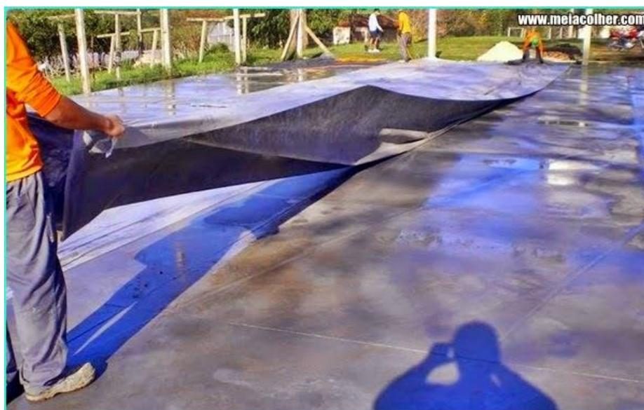
Figura 4 - Cura úmida do Concreto com lona
