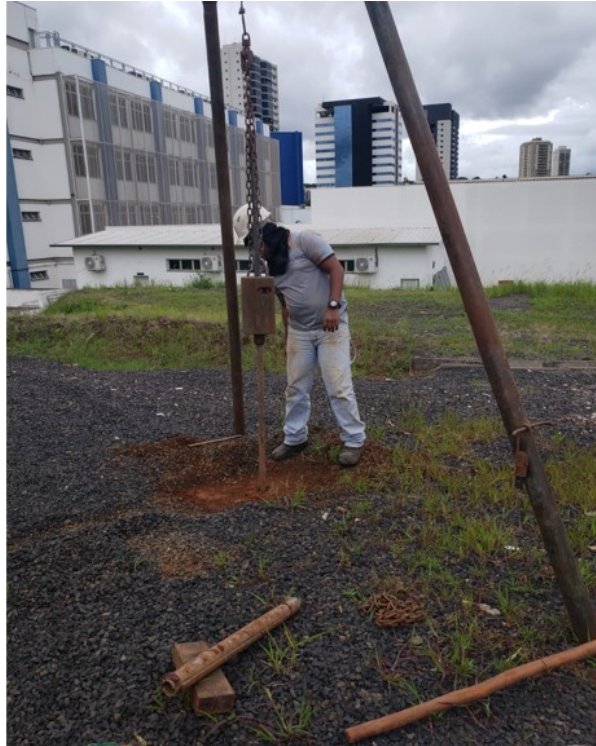
Foto 2: Foto da execução da Sondagem SPT 02 Fonte: Autoria própria
