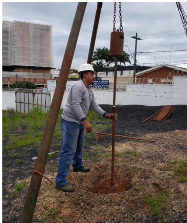
Foto 3: Foto da execução da Sondagem SPT 03 Fonte: Autoria própria
