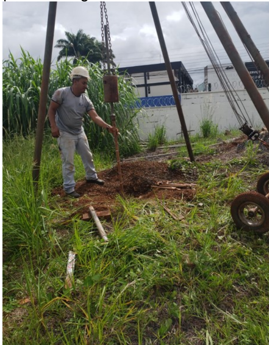
Foto 1: Foto da execução da Sondagem SPT 01
