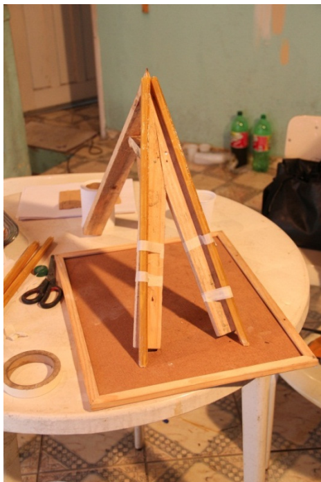
Gabarito de montagem da tesoura
