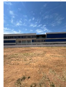
FOTO 06: VISTA INTERNA DO IMOVEL
