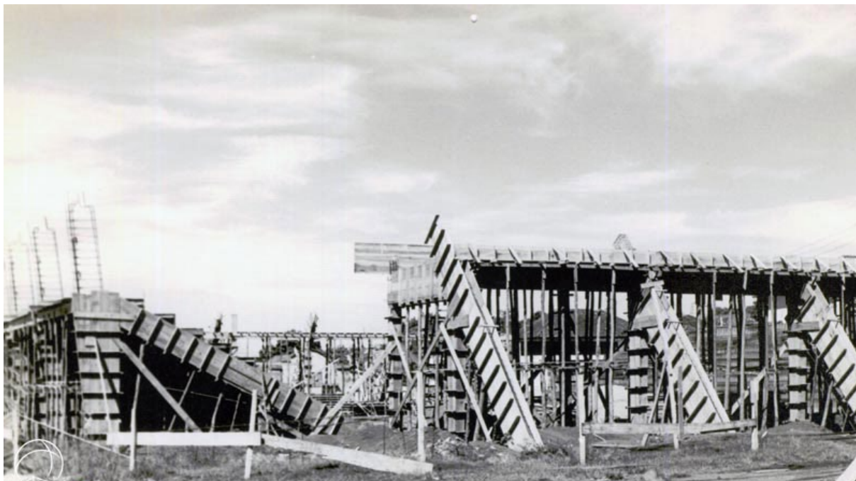
Imagem 5: Construção do complexo esportivo Clube dos Bagres.
